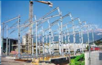
Im Bau: ATZWANGER Bozen
