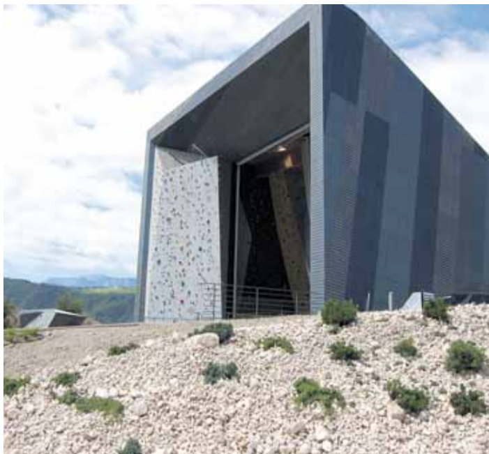
Die Begrünung vor der Kletterhalle wurde von der Fa. Rasenfix ausgeführt.
