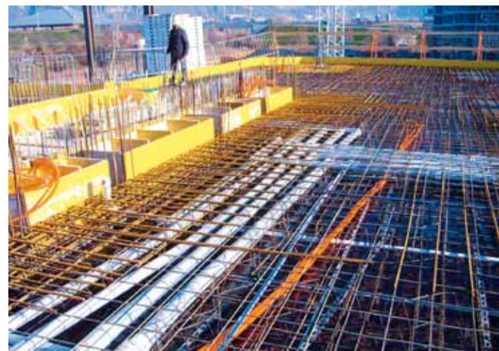
Anlage Bauteilaktivierung
