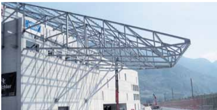
Frei auskragende Fassadenunterkonstruktion aus Stahl
