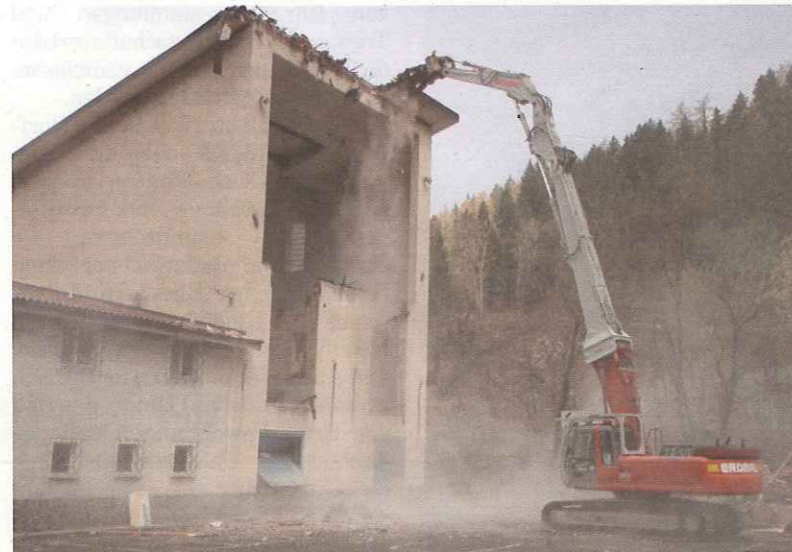
Meran 2000: Der Abriss der alten Talstation und die neue
